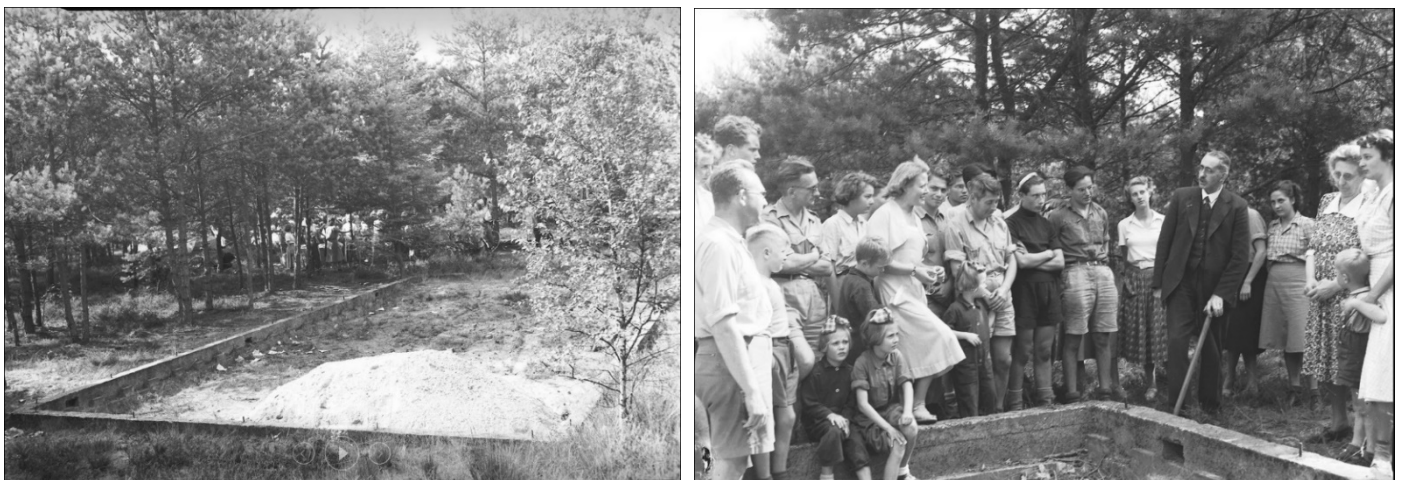
Dalton bouwkamp 1950 op Zonnewende. Op de fundamenten v/h VCJC kampeerhuis wordt nieuwbouw geplaatst. 2 e rechts mevr. A. Sillevis.
